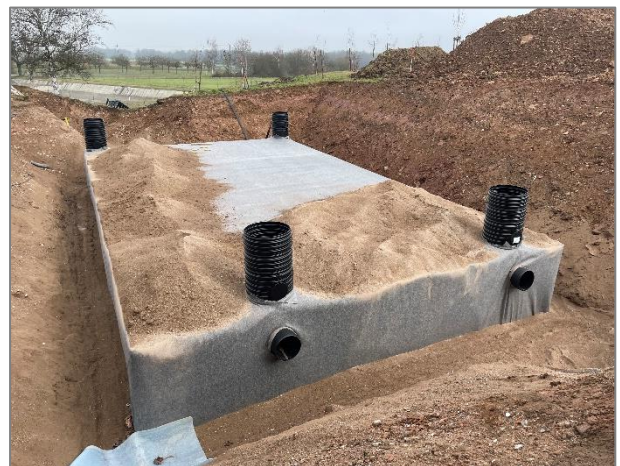
Oben: Versickerungsfähiges neues Pflaster; Unten: Regenwasserzisterne der Firma Kurtz Ersä in Kreuzwertheim. Fotos: Kurtz Ersä
