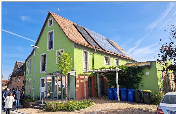
Oben: Die Energie-Scheune von außen. Mitte: Ofen und Wärmeverteiler in der Energie-Scheune. Unten: Das Ärztehaus in der alten Schuhfabrik. Fotos: Anne Weiß
